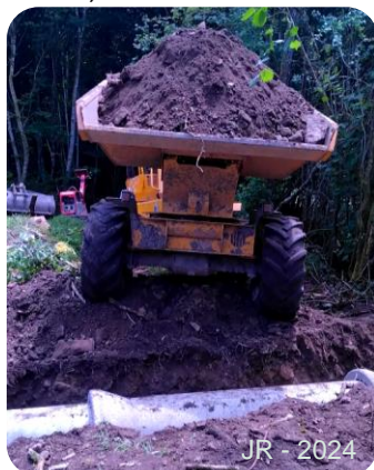
Chemin après travaux – JR
